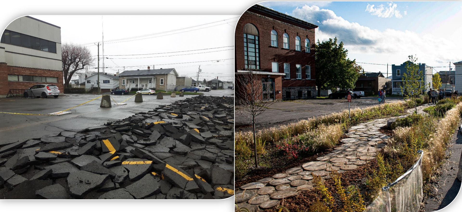
Stationnement du Centre communautaire Raphaël-Barrette, Salaberry-de-Valleyfield
